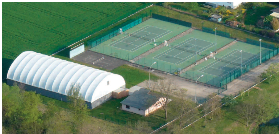
Les installations du TC Issenheim
